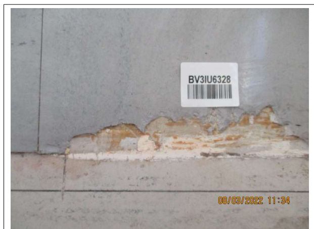
Prélèvement - P001 : Rectorat / 1er Etage / Bureaux inspecteurs - Dalle de sol- (Présence d'amiante)
