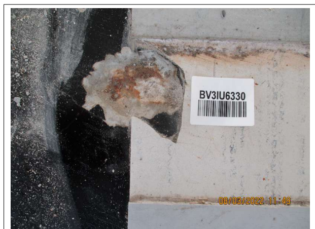
Prélèvement - P003 : Rectorat / 1er Etage / Bureaux inspecteurs - Dalle de sol- (Présence d'amiante)
